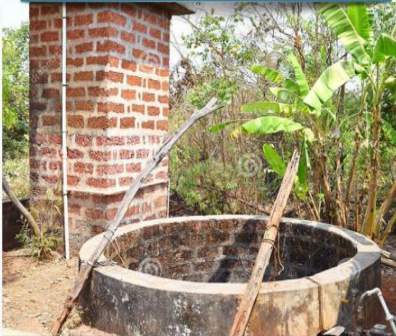
Les Puits asséchés
