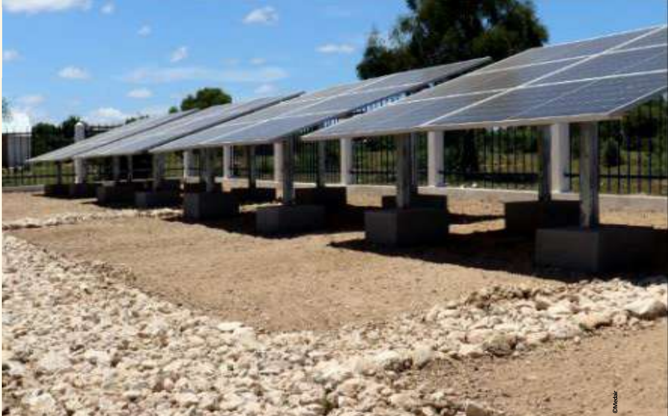
Mise en place d'un parc solaire (42 panneaux pour alimenter la pompe)
