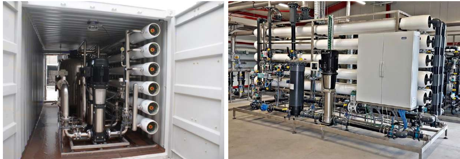
Station compacte en container de désalinisation d'eau de mer par osmose inverse
