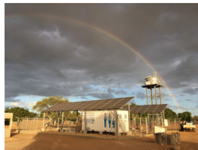
Unité de traitement solaire d'eau saumâtre OSMOSUN® pour l'alimentation en eau potable des communautés au Mozambique
